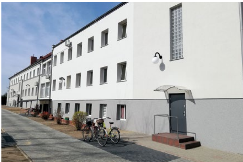
Gmach przy ul. Kosieczynskiej 4 po różnych remontach. Widzimy zespolone ze sobą Pawilon A, Pawilon B i jako łącznik między nimi Pawilon C. Widok – od strony torów.
